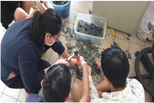
圖 30 石板的大小需要修，一塊一塊敲碎再組裝
